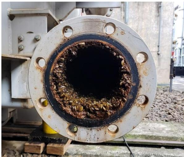
Photo : Moules zébrées dans un conduit de traitement d'eau<sup>6</sup>
