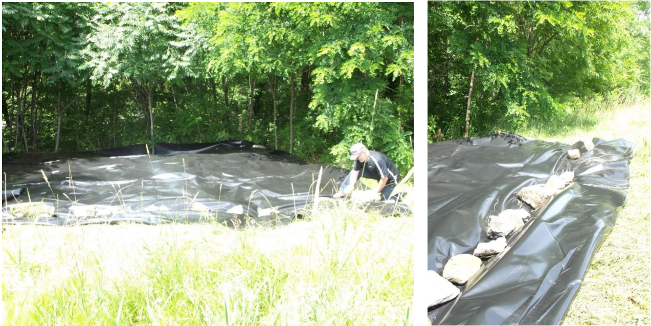
Après une coupe, une bâche est installée et fixée au sol avec des roches. (Exemple de bâche : Texel Série 800 environ 2,53$/m 2 )
